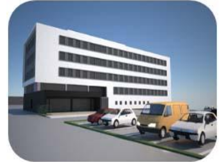
Nye kontorer, Haugesund
